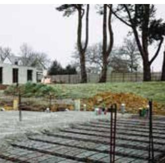
**7** Mettre en place le ferrailage complémentaire de la dalle conformément au plan de pose.
