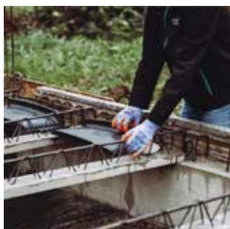
**1** Placer les poutrelles sur les appuis. Régler l'entraxe des poutrelles en positionnant un tympan ELR-A à chaque extrémité.
