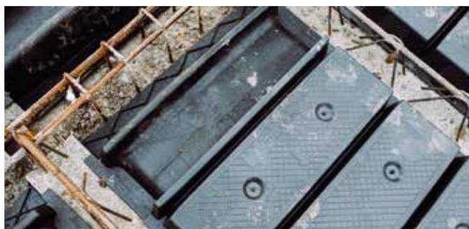
**2** Mettre en place la ou les files d'étais si nécessaire, en les réglant de niveau avec l'arase de maçonnerie.
