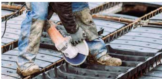
**5** Découper si nécessaire le dernier entrevous pour un réglage à la longueur souhaitée. La découpe se fait toujours en fond de nervure. Ajuster ensuite la répartition des ELR en faisant jouer l'effet tiroir sur les ELR-A.
