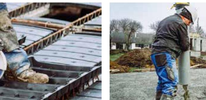
**6** Se conformer au plan de pose pour traiter la zone entre la dernière poutrelle et le mur (entrevous ELR entier ou entrevous polystyrène découpé).
